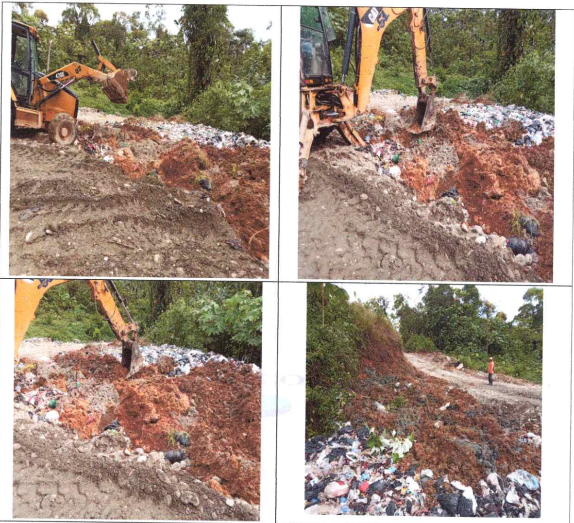
Cubrimiento de residuos solidos Con Material Seleccionado
