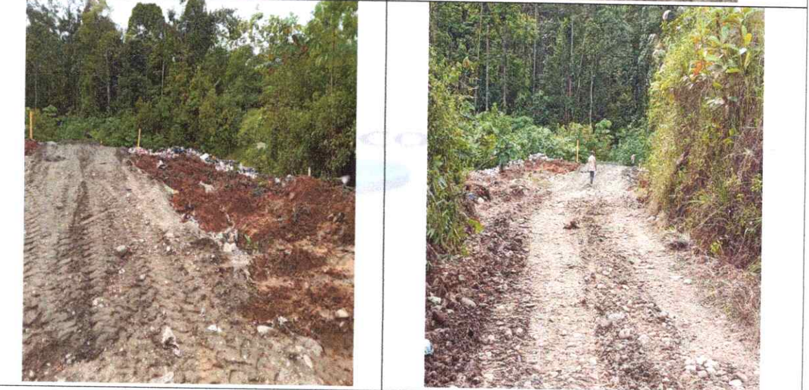
Afirmado para la vía de acceso a la celda Con Material Seleccionado
