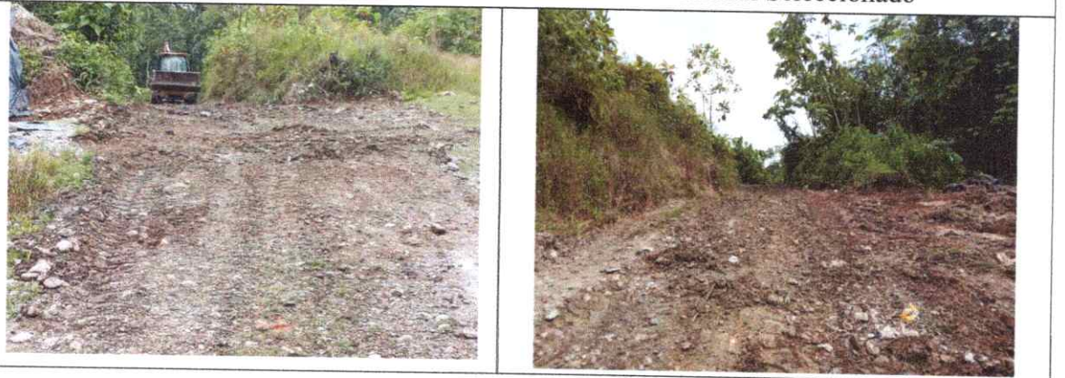
Afirmado para la vía de acceso a la celda Con Material Seleccionado
