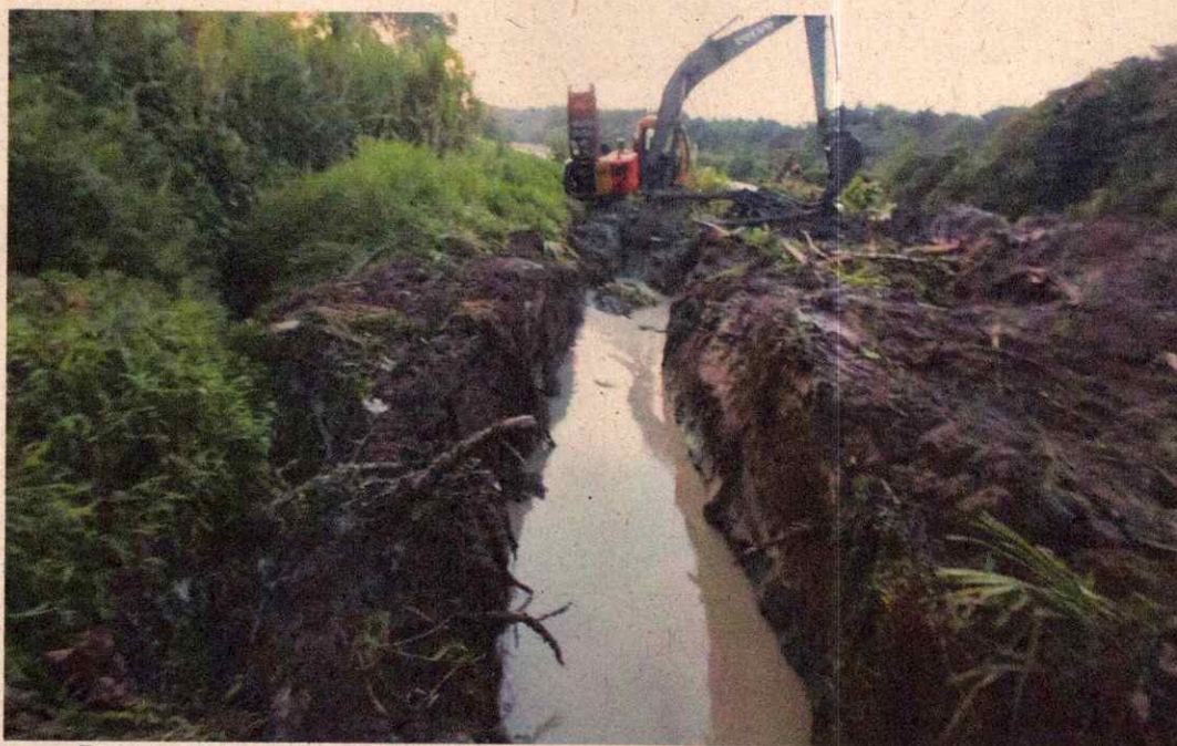
Registro Fotográfico N° 11. Canalización del punto final descole del alcantarillado
