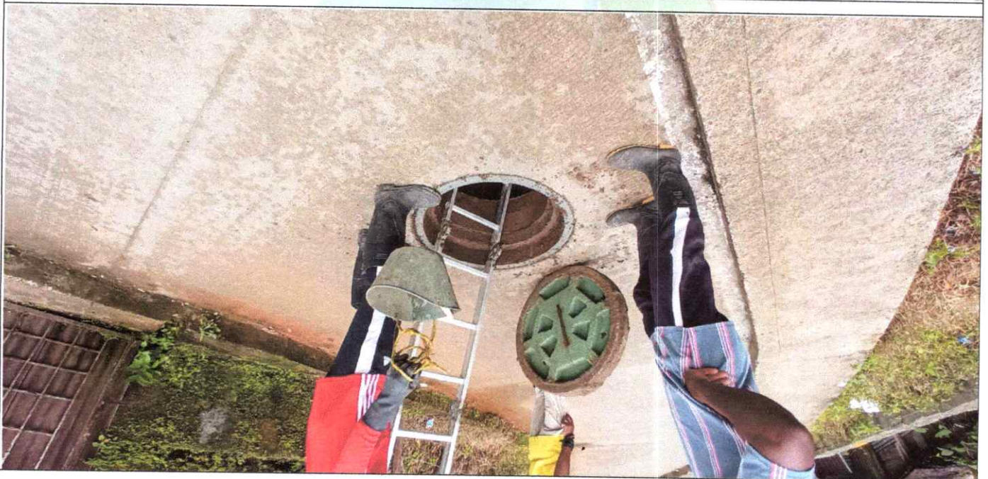
Extracción de sedimentos
