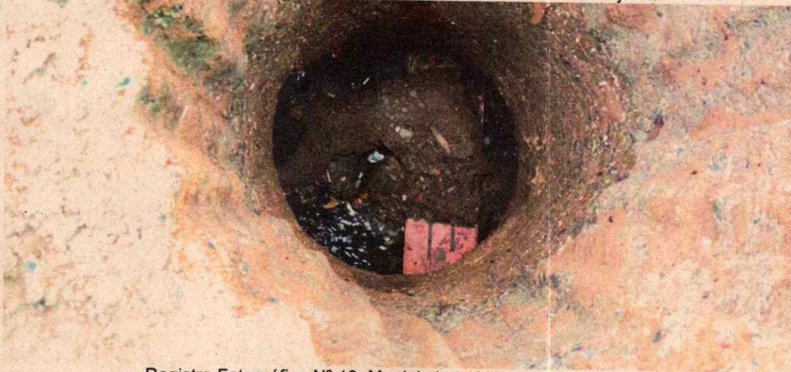
Registro Fotográfico N° 10. Manjol obstruido por sedimentos .
