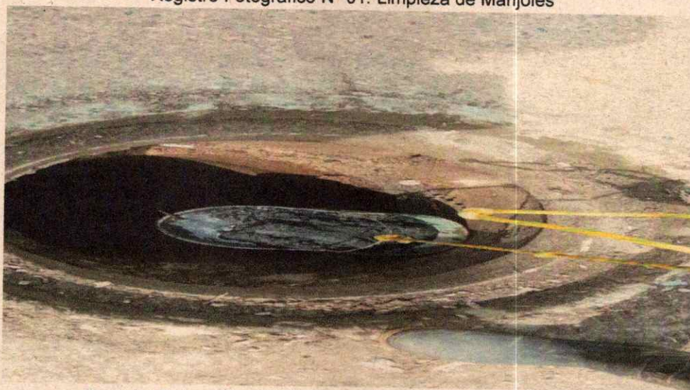
Registro Fotográfico N° 02. Retiro de sedimentos a los Manjoles
