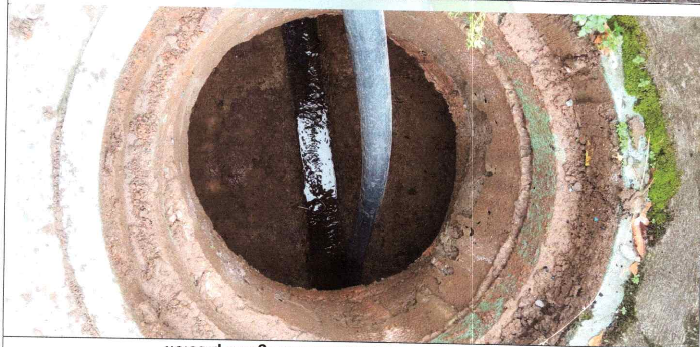
Limpieza red de alcantarillado con agua a presión
