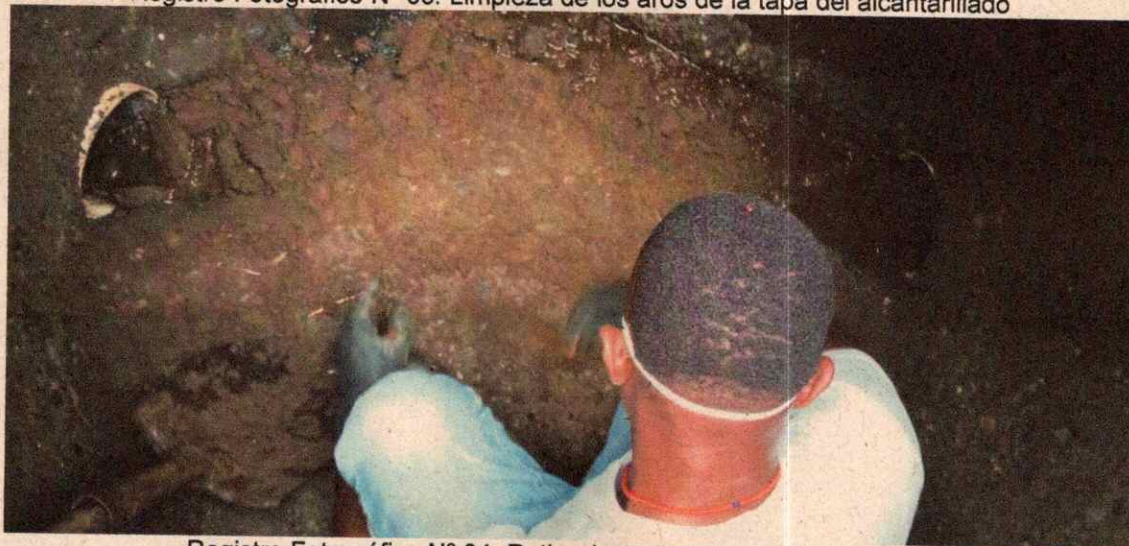
Registro Fotográfico N° 04. Retiro de sedimentos en los manjoles
