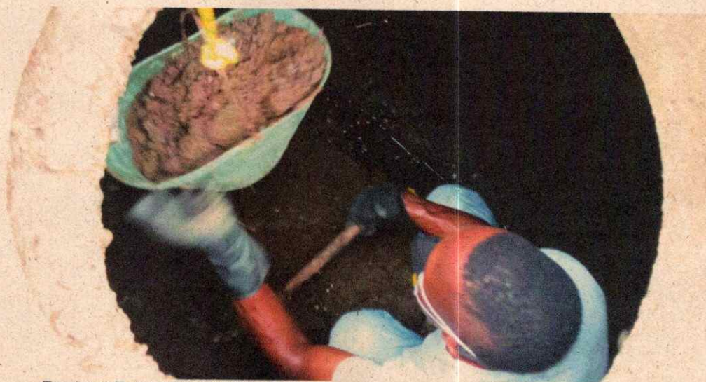
Registro Fotográfico N° 05. Retiro de sedimentos en los manjoles
