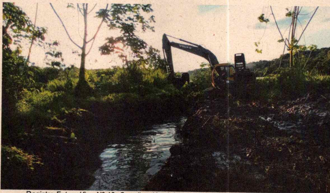
Registro Fotográfico N° 13. Canalización del punto final descole del alcantarillado.
