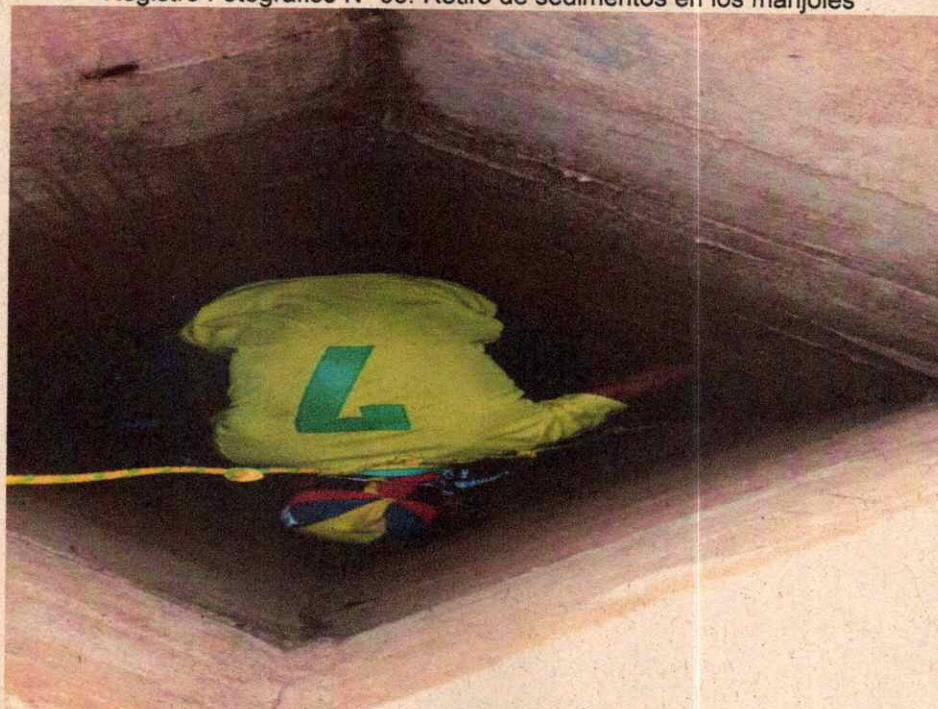
Registro Fotográfico N° 06. Limpieza de caja del sistema de alcantarillado
