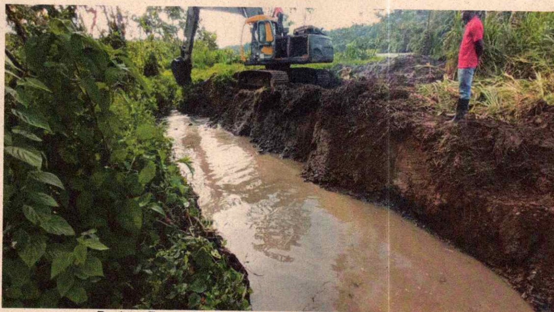
Registro Fotográfico N° 14. Retiro de sedimentos de manjól.
