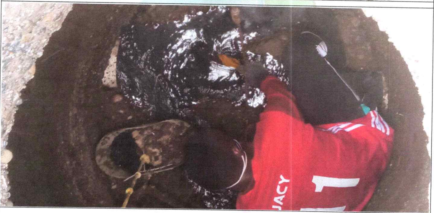
Extracción de sedimentos
