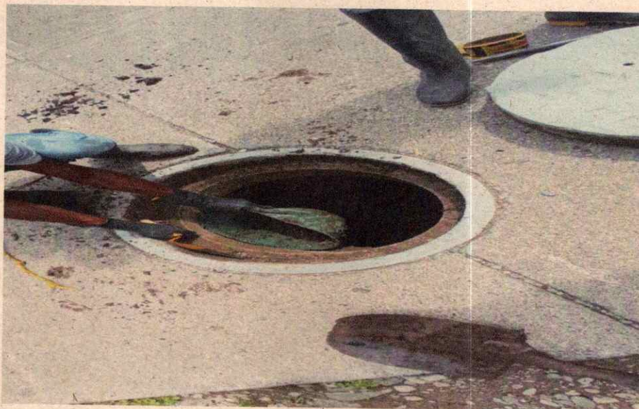
Registro Fotográfico N° 03. Limpieza de los aros de la tapa del alcantarillado
