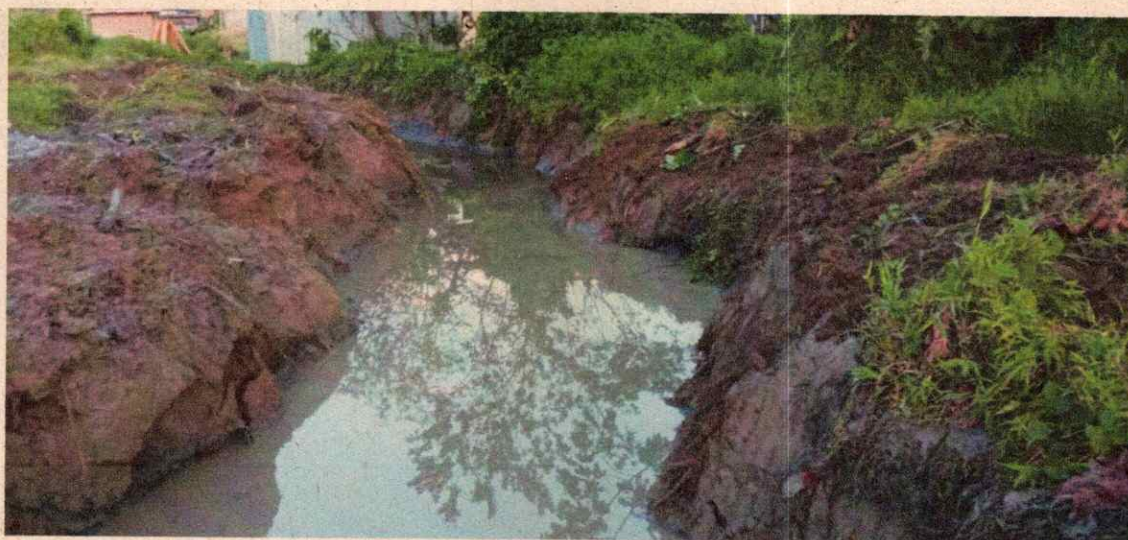
Registro Fotográfico N° 12. Canalización de descole del alcantarillado.
